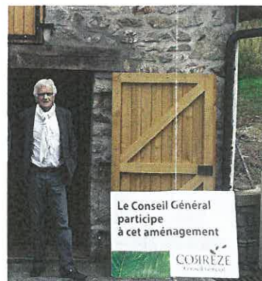
Rénovation four communal - octobre 2014
